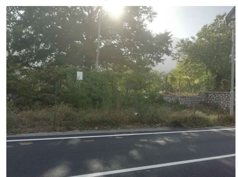
Area al km +5,4
