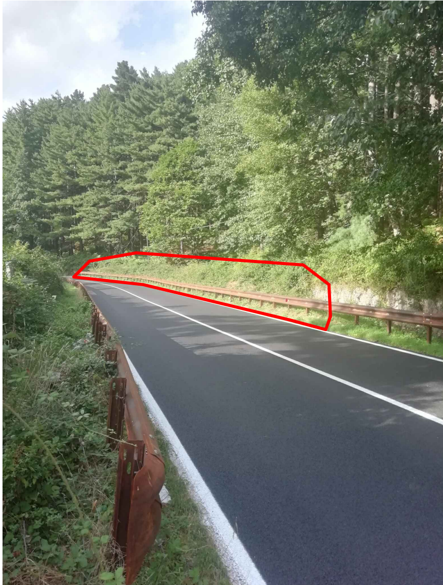
Area di sosta al km +4,3
