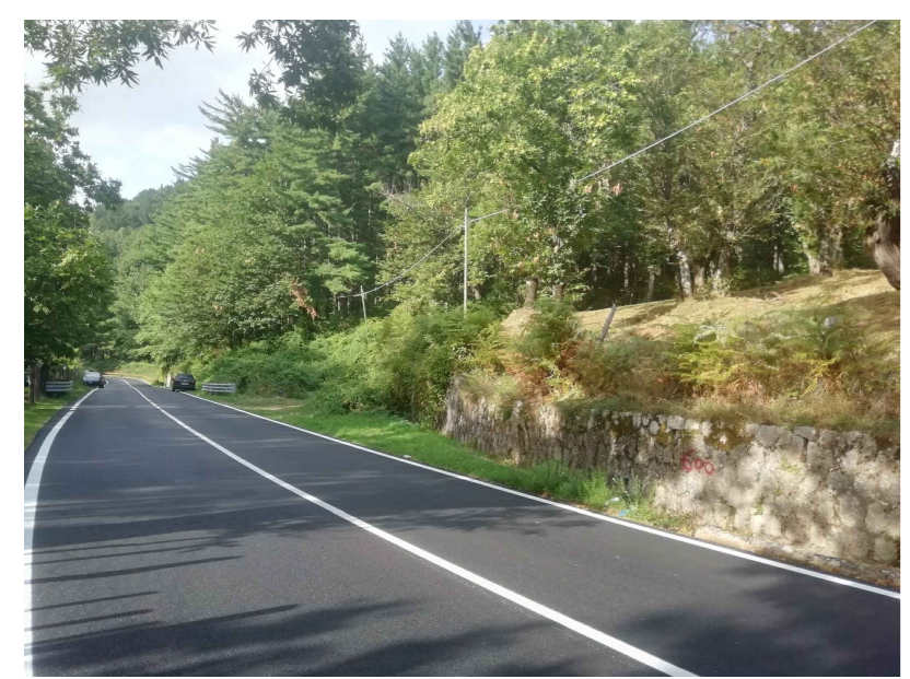
Area di sosta al km +4,4
